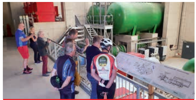
Wasserentnahmestelle beim Kraftwerk Knappengasse
